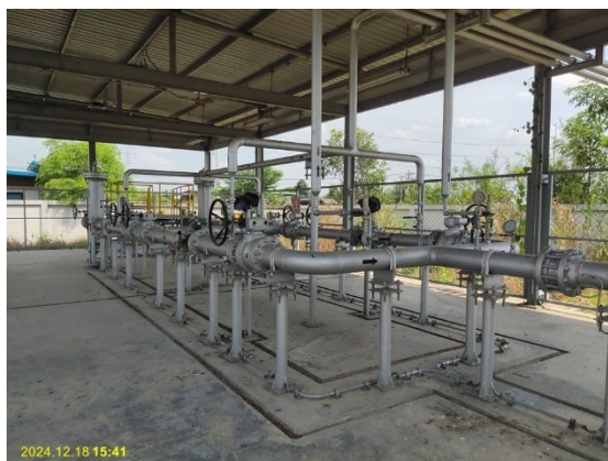
อาคารควบคุมความดันและวัดปริมาณก๊าซ (Metering & Regulating Station)
